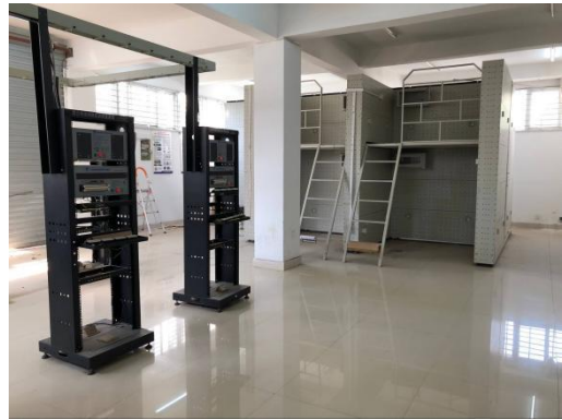
图 6-7 网络综合布线实训室
